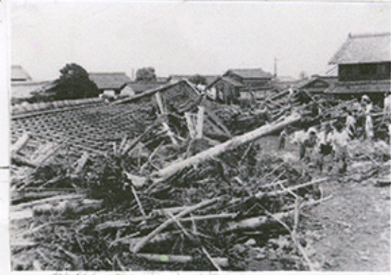
被災した玉水地区
