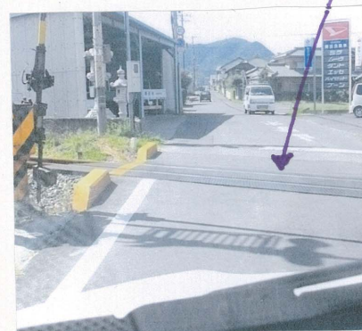
線路のまわりに置いて(おて)いるのは、色はちがいますが、どちらもゴムです。左側は夕々に、右側は陸上のトラックに似ています。ふみ切に高低差があって、車が右にひかかっていたのがなくなりました。(高瀬駅近く)
