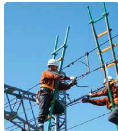
でんしゃ でん き おく でんしゃせん てんけん 電車に電気を送る電車線の点検
