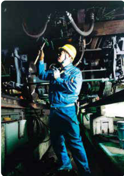
でんしゃ ゆかした てんけん 電車の床下の点検
