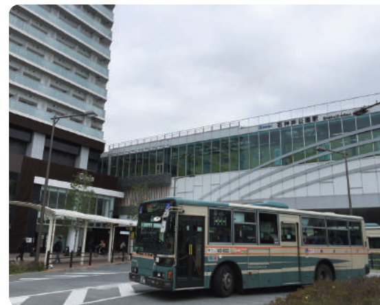
高架化された石神井公園駅（東京）
