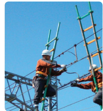
でんしゃ でん き おく でんしゃせん てんけん 電車に電気を送る電車線の点検
