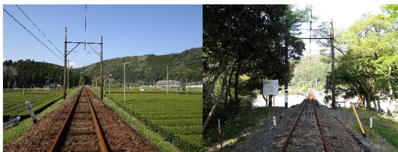
ここを歩きます抜里駅付近(左)、折り返し地点 大井川第一橋梁抜里側(右)
