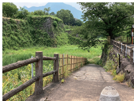
堀に入るスロープ。雑草に覆われた道が石垣へと続いている。
