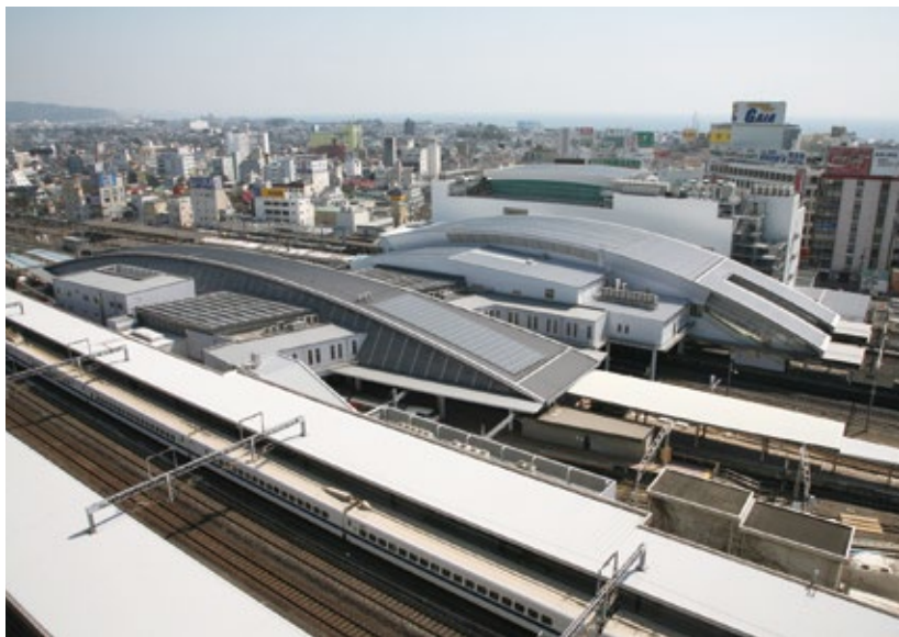
小田原駅に設置された太陽光発電パネル。小田急電鉄では12駅に太陽光発電パネルを設置し、その電力を構内の照明やエスカレーター等に使用している。(写真提供：小田急電鉄株式会社)
