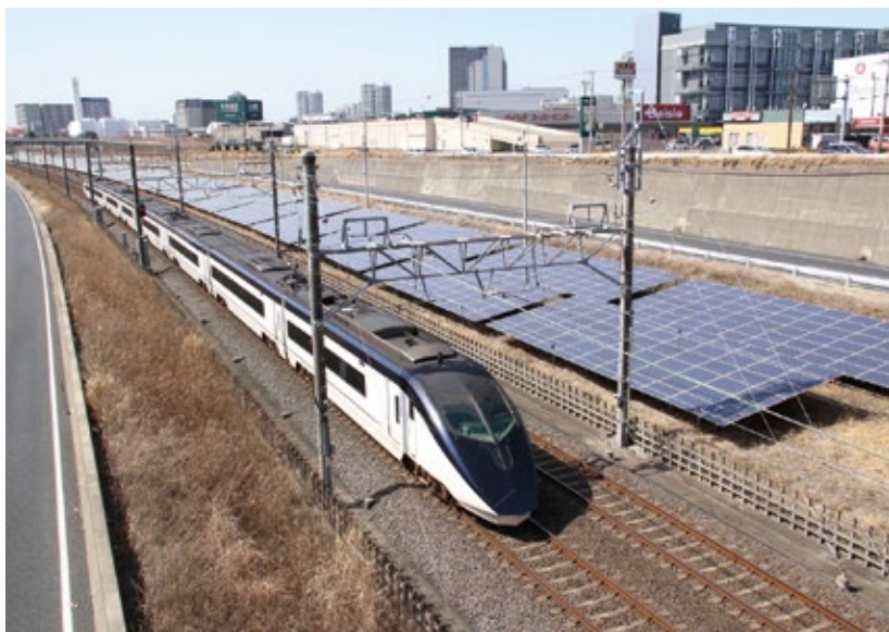
SGET 千葉ニュータウンメガソーラー (12.8MW) の横を走行する「スカイライナー」。北総鉄道北総線に沿って約10kmにわたり太陽光パネルが設置されている。トラッキング付FIT 非化石証書を通してCO 2 排出量実質ゼロのスカイライナーにも利用されている。(写真提供：京成電鉄株式会社)
