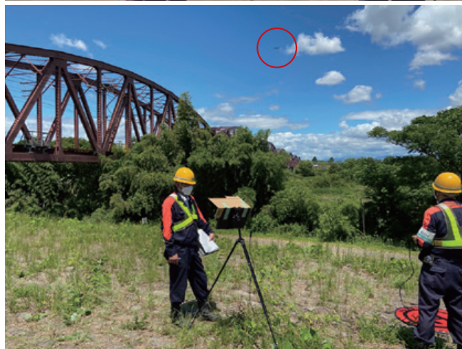
上/天白川橋梁でドローンを使った点検 下/木曽川橋梁でドローンを使った点検
