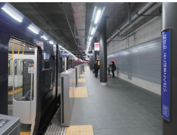
相鉄・JR 直通線開業で新設された羽沢横浜国大駅
