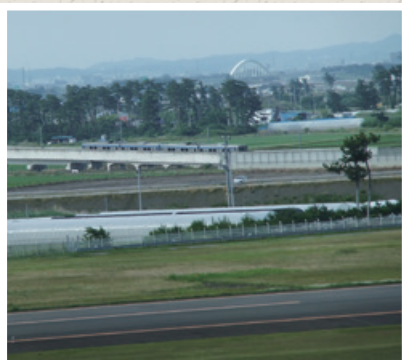
高架が低くなってトンネルへ（写真左）。トンネルの出口は駐機場の真横（写真右：中央のあたり）。
