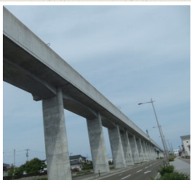
下からでは高架橋の上を走る電車は見えない。
