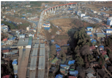
空港へ伸びる空港新線の工事 (1971年)
