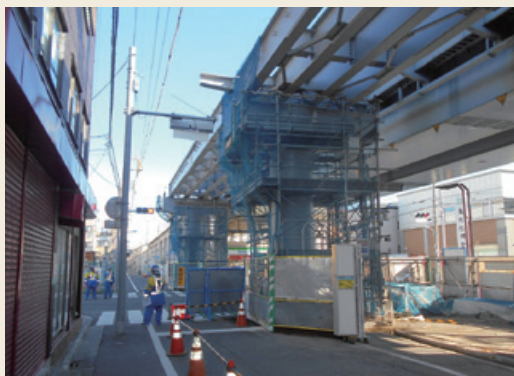
四ツ木駅—青砥駅間の連続立体交差事業が進んでいる
