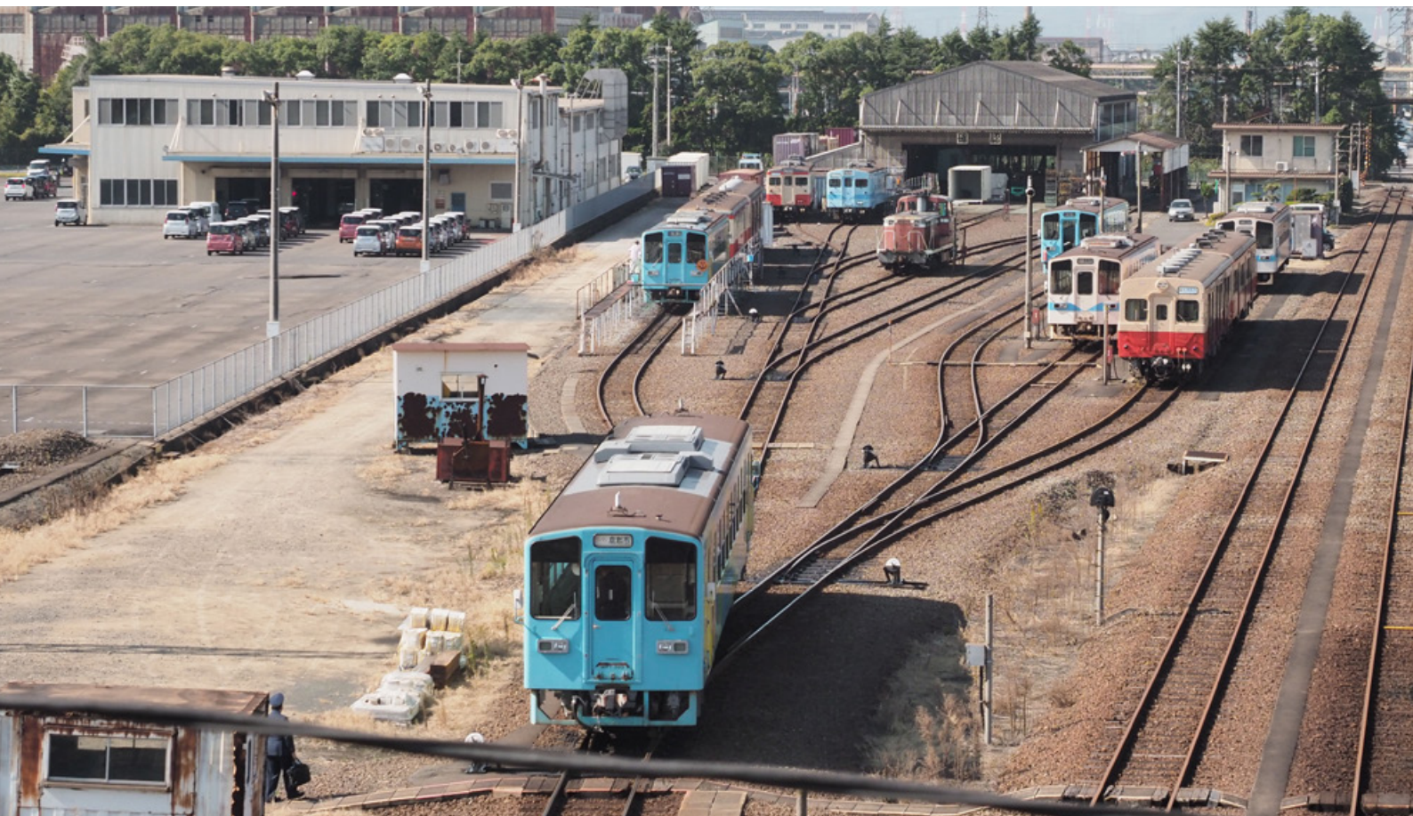
貨物駅の倉敷貨物ターミナル駅。車両基地が併設され、旅客列車車両が乗り入れている
