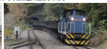
上／関谷トンネルを通過する 左／盛駅に置かれている車両基地
