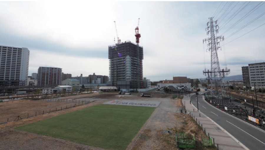
「ViNA GARDENS」の「くらしエリア」ではタワーマンションの建設が進む
