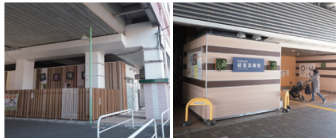
高架下空間には学童保育施設（梅ヶ丘）や図書館（経堂）などを整備
