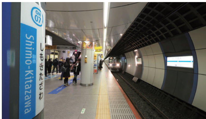
シールド工法でつくられた急行線ホームは、壁面が曲線を描く
