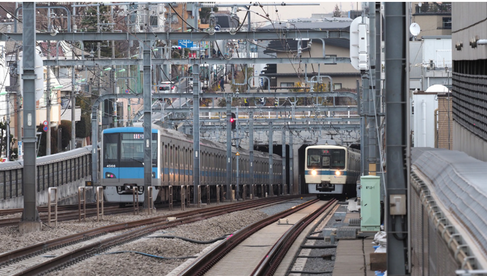
世田谷代田駅付近の坑口。ここから2線2層の地下式構造となる
