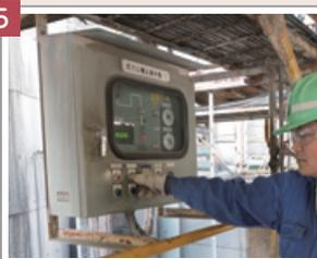
すぐ横にある「炭カル積込操作盤」のボタンを押して積載開始。操作盤には計量器の表示がある。それを見ながら所定の量まで入れる。所要時間約17分。
