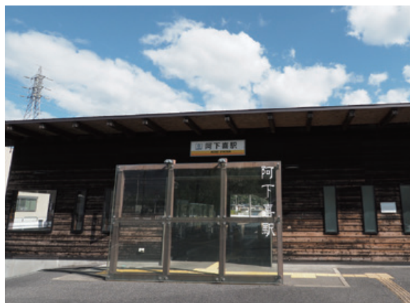
終着の阿下喜駅も2006年に駅舎を新築した（北勢線）
