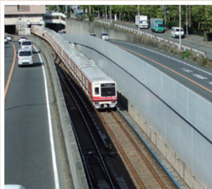
桃山台駅近くの歩道橋の上から。 北大阪急行電鉄の8000形「ポールスター号」
