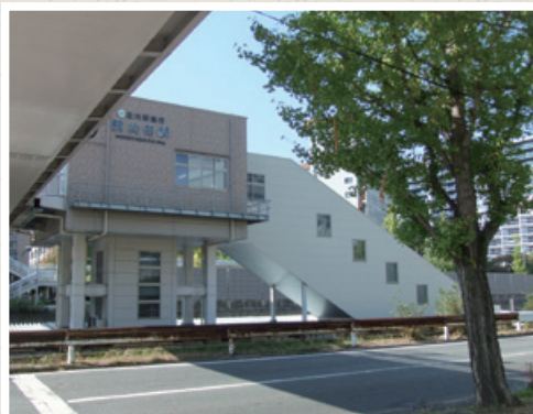
桃山台駅。改札は1階と2階にあり、ホームは地下。歩道からではホームは見えない
