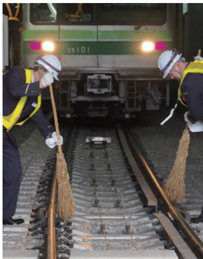
レールの継ぎ目を竹ぼうきで掃く。
