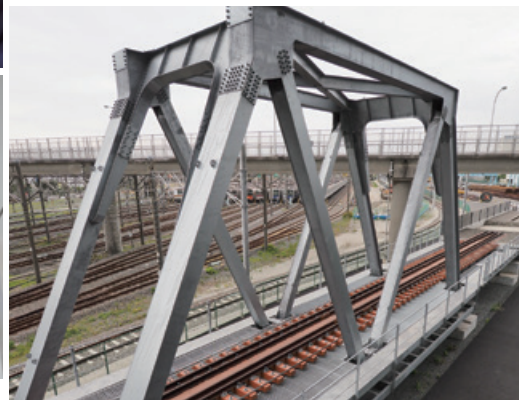
訓練用の橋梁・高架橋は4種が設置されている。
