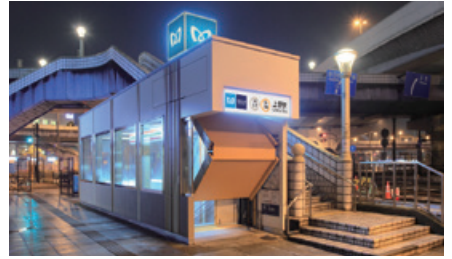
銀座線上野駅に整備されたホームドアと完全防水型の駅出入口。
