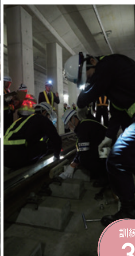
左/トンネル内で折損箇所を探す。右/復旧に取り組む工務部スタッフ。
