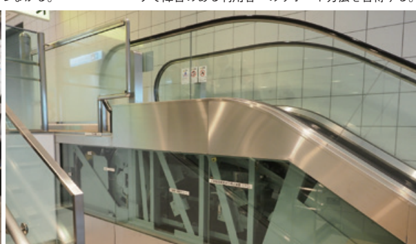
駆動部分がガラス張りで見組みが見られるようになっている。
