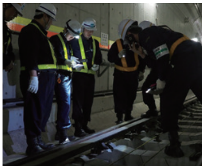
左/トンネル内で折損箇所を探す。右/復旧に取り組む工務部スタッフ。
