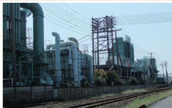
列車は工場の真横を走り抜けていく。
