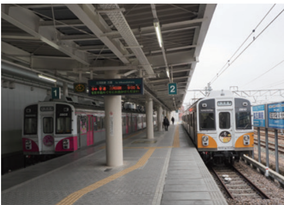
1面2線の新豊橋駅ホーム。
