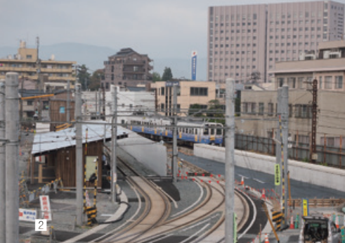
1 平成 27 年 9 月 27 日に開業した三国芦原線の「まつもと町屋駅」。行き違い設備のない無人駅だが屋根付きスロープやホーム屋根が設置されている。2 えちぜん鉄道三国芦原線と福井鉄道福武線が接続する田原町では、相互乗り入れに向けた工事が進む。3 4 平成 26 年に運行を開始したえちぜん鉄道初の観光列車「きょうりゅう電車」。ティラノサウルスの頭部が装飾されている。
