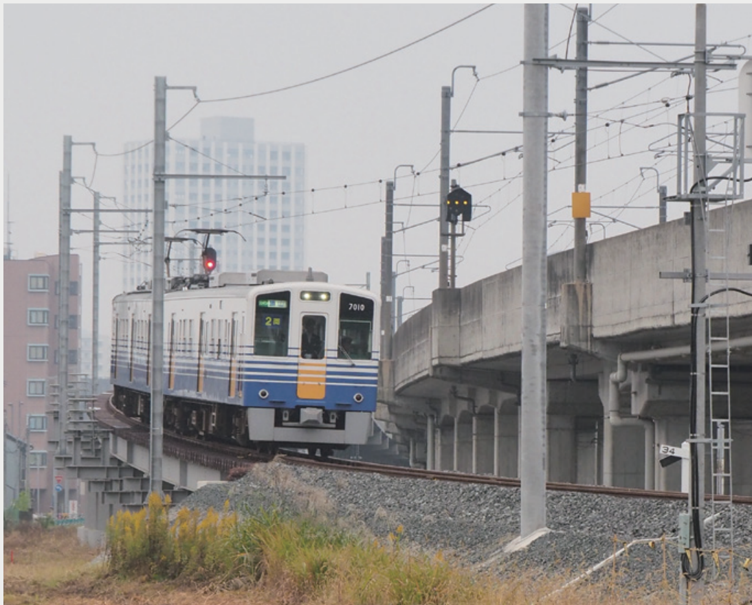
北陸新幹線開業に向け、福井駅周辺では連続立体交差事業が進められている。えちぜん鉄道では平成 27 年 9 月より、福井-福井口間で北陸新幹線用高架橋を使用しての仮線営業運転を開始。単独の高架を建設した後、仮線から切り替える計画だ。
