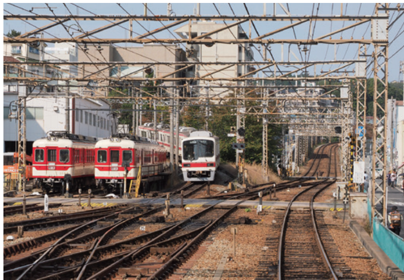
鈴蘭台から、複線で直進する有馬線に対し、単線の粟生線は大きく左にカーブして急勾配を駆け上がる。
