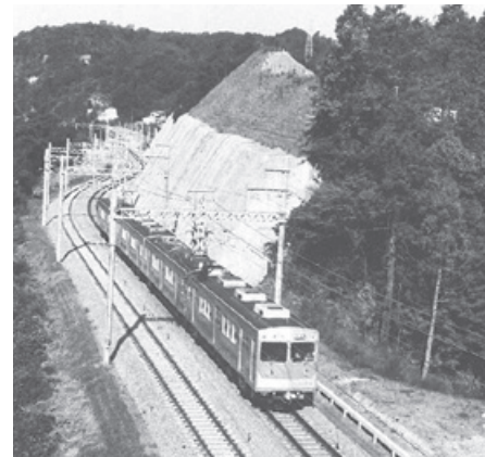
上／1979年、朝の粟生線鈴蘭台上りホーム。 下／神戸電鉄は複線化工事など輸送力増強に努めた。写真は鈴蘭台西口―藍那間。（写真提供：神戸電鉄株式会社）
