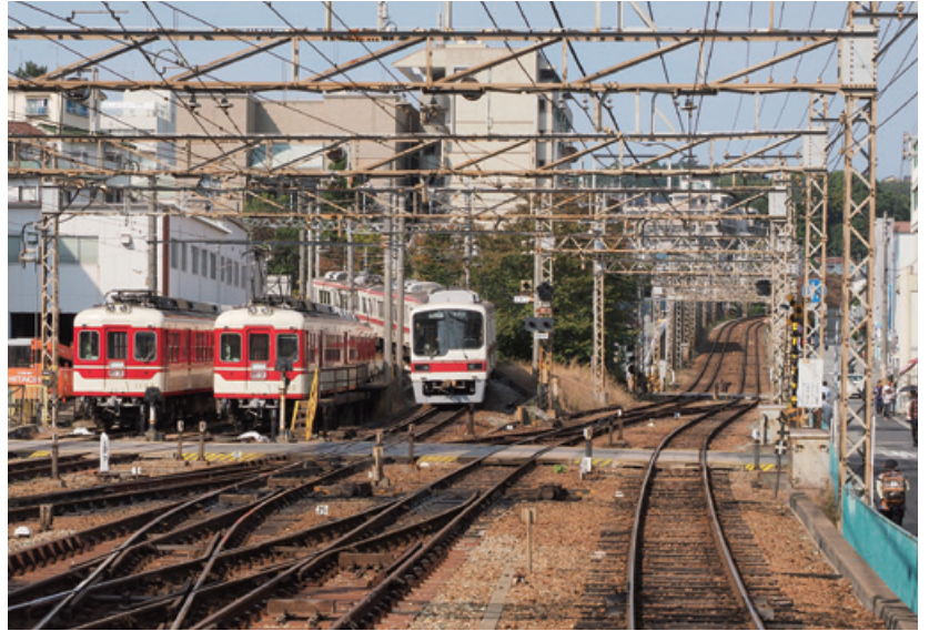
鈴蘭台から、複線で直進する有馬線に対し、単線の粟生線は大きく左にカーブして急勾配を駆け上がる。
