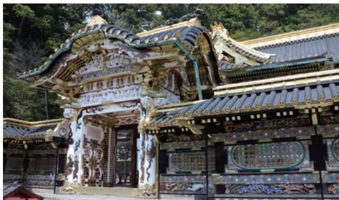
約4万9000㎡の敷地内に55棟の建物が建つ日光東照宮。本社の正門である唐門は大祭や国賓などが参拝するときのみ使用される
