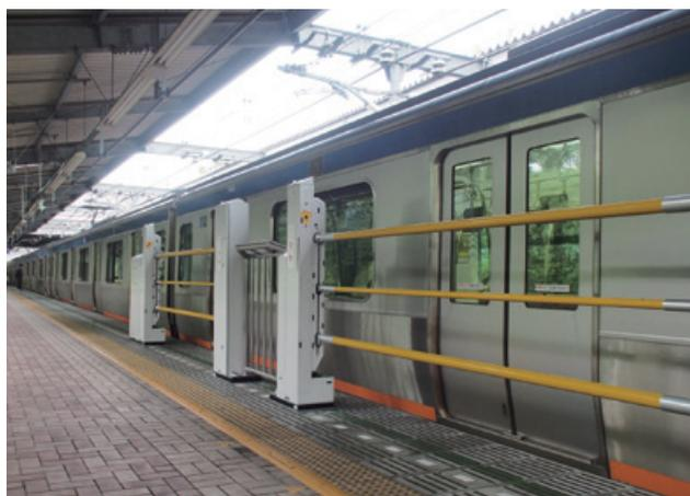
相模鉄道いずみ野線弥生台駅に設置された昇降バー式ホームドア。列車運行への影響や安全性、バーの昇降速度や機能面について検証を行う。
