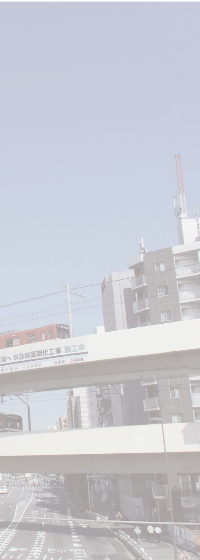
京急蒲田駅付近連続立体交差事業で2層高架式になった京急蒲田駅
