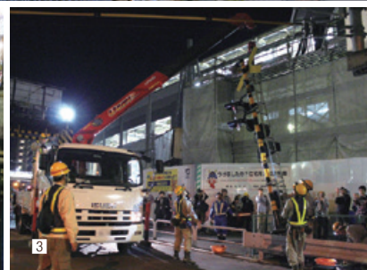
1 直接高架工法では、営業線を活かしたまま線路の真上を跨ぐ形で高架橋を構築する。2 3 線路高架切替は、終車から始発までの3時間50分という短い時間を使って行われた。
