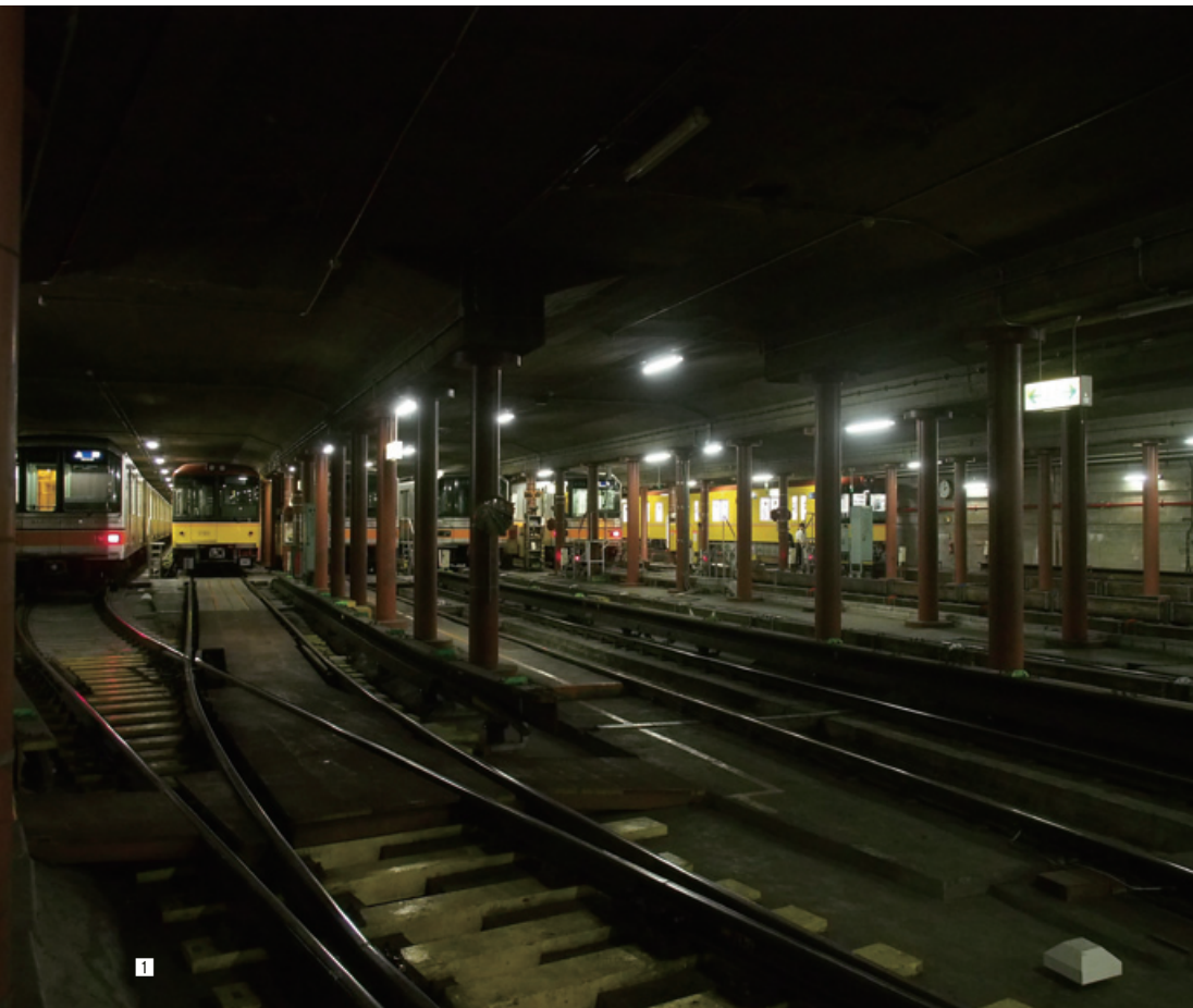
1 銀座線を検査する上野検車区。地上部6両編成7本、地下部6両編成13本の留置能力がある。2 耐震補強工事が実施された高架橋。3 丸ノ内線地上部の石積み擁壁。
