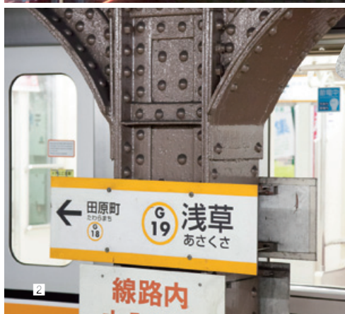
1 高所作業車による特別全般検査。2 浅草駅のリベット打ち支柱。浅草-新橋間は「近代化産業遺産」に認定されている。3 利用客への情報提供に活用される改札口ディスプレイ。4 帰宅困難者対策として各駅では水やシートを備蓄している。
