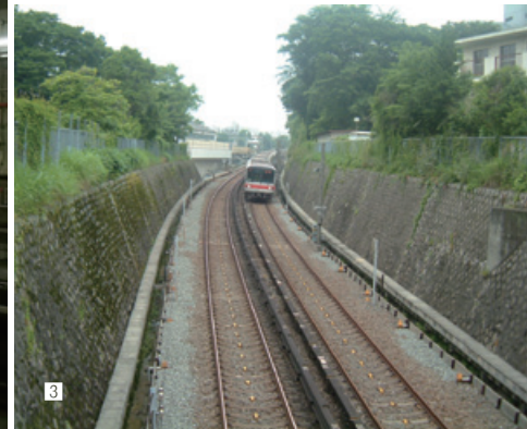
1 銀座線を検査する上野検車区。地上部6両編成7本、地下部6両編成13本の留置能力がある。2 耐震補強工事が実施された高架橋。3 丸ノ内線地上部の石積み擁壁。
