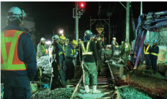
11月24日未明に行われた線路切替工事（写真・遠州鉄道株式会社）
