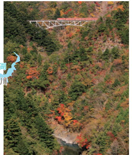
関の沢橋梁を渡る井川線南アルプスあぶとライン
