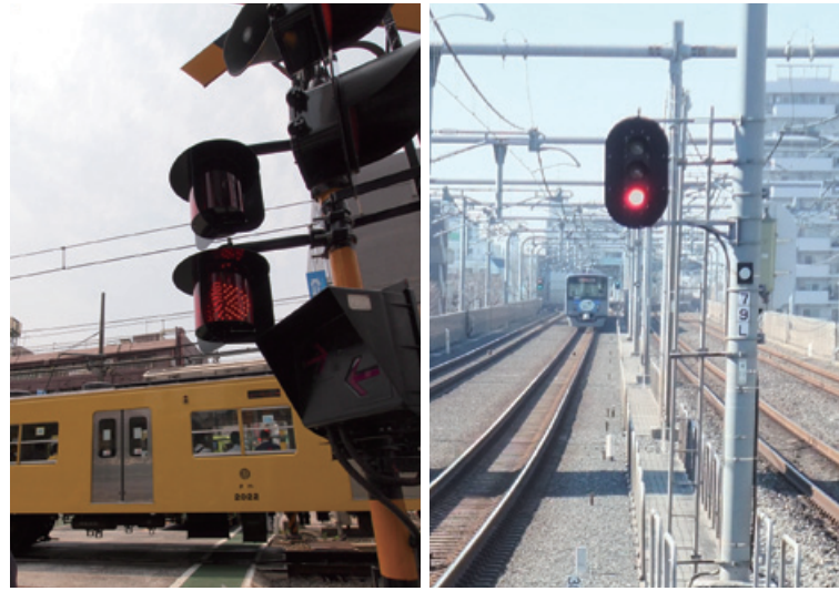
付帯用電力の「信号高圧」は、安全を守るさまざまな設備に使用される。西武鉄道では、より省エネ効果の高い安全設備装置の導入を積極的に進めている。踏切や信号などのLED化もその一つだ。1997年から進めていた信号のLED化の切り替えは現在ではほぼ終了している。
