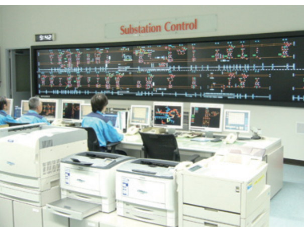
電力の安定供給と列車の安全運行を支える電気司令。
