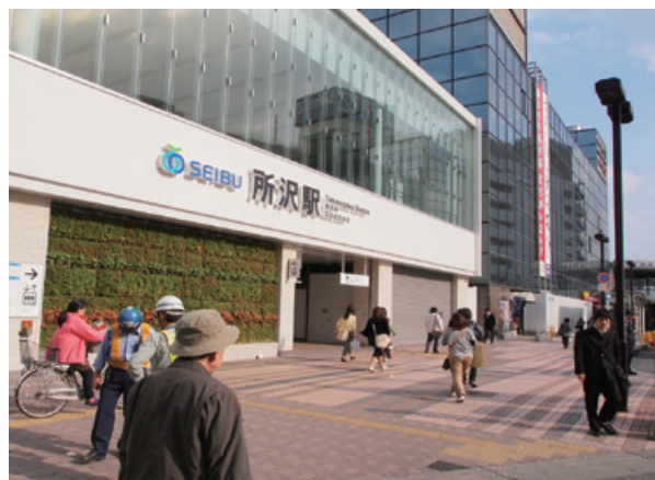
改修工事が進む所沢駅。新しい駅舎の一部はすでに使用が開始されている。
