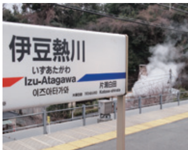
ホームそばに源泉がある伊豆熱川駅
