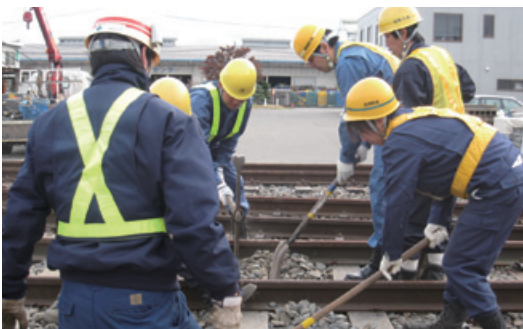
講義と実習で保線作業の実務を学ぶ保線実技研修（平成22年11月15～18日：3泊4日）。17事業者24人の保線担当者が参加した
