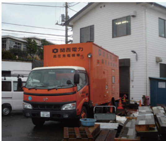
東京電力を通じて借りた関西電力の高圧発電機車。七里ヶ浜変電所に設置して活用した
