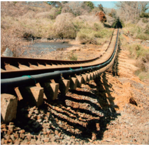
溜め池の決壊で路盤の盛り土が流出、宙に浮いた線路。
