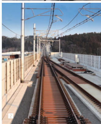
1 成田湯川駅から成田空港方は単線になっている。根古屋信号場付近を走る新型スカイライナー 2 分岐角度 1.3 度で時速 160 km 走行を可能にする全長約 135 m のノーズ可動 38 番分岐器 3 成田空港駅 4・5 番線に新型スカイライナーが発着する
