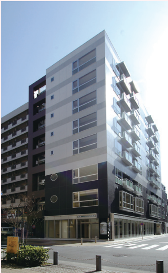
子育て施設が整備された「京王安フィール高幡」
