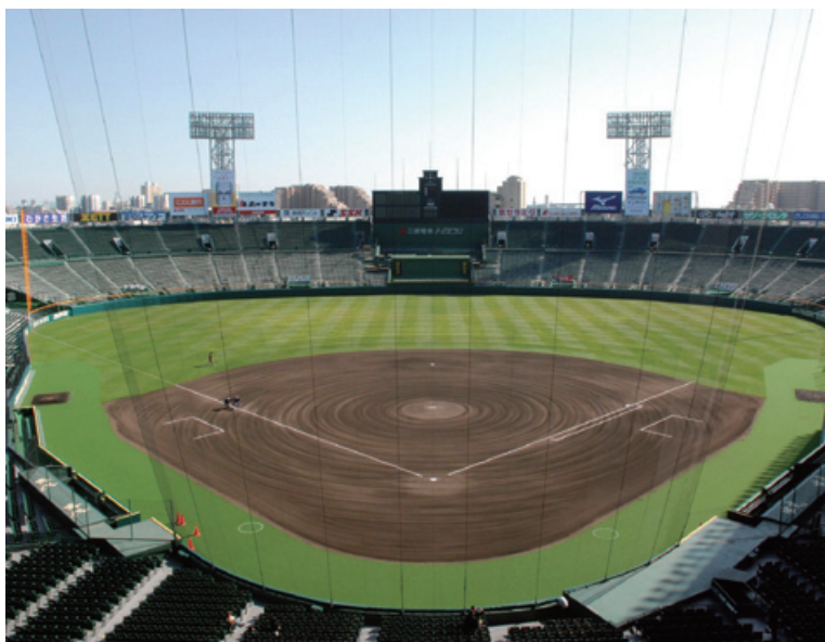
リニューアル工事が完了し、新しく生まれ変わった阪神甲子園球場。
