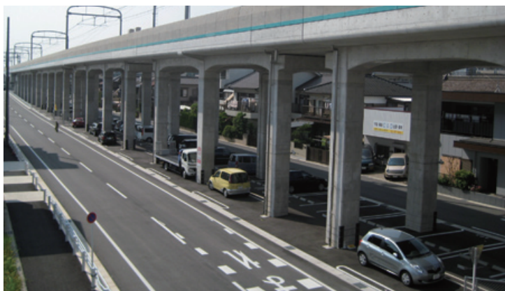
高架化事業に合わせて整備された名古屋本線鳴海駅パーク＆ライド駐車場
