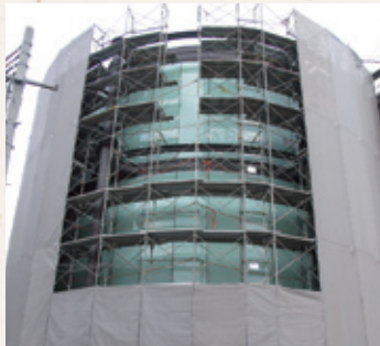
円柱の外観がおおよそ地下駅の入口とは思えない九条駅の地上ゲート。
