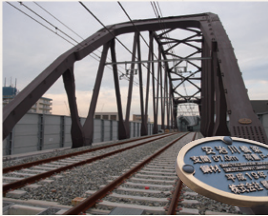
安治川橋梁。防音壁はしール面から2mの高さなので、車窓から景色が楽しめる。
