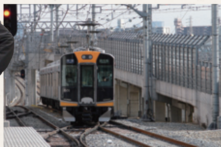
阪神本線下り線と阪神なんば線を立体交差させるため新設された高架橋。
