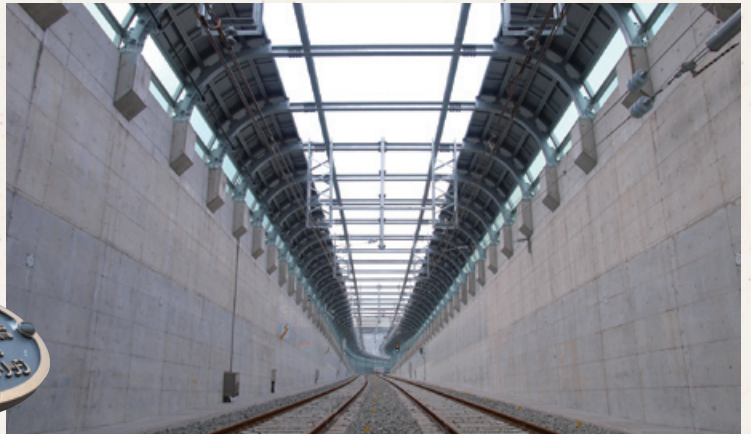
セミシールド型防音壁。上部が半透明板で明るい印象を受ける。
