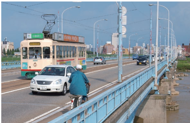
富山大橋を走る市内電車。新しい橋では複線化になる。
