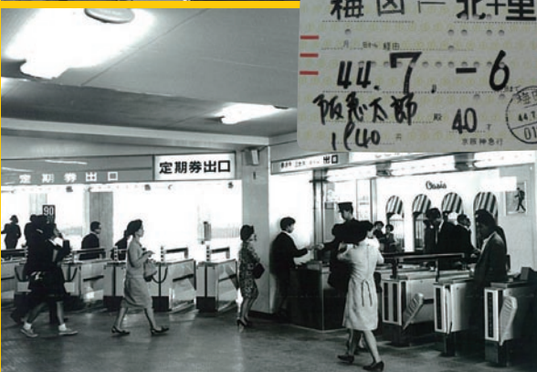
↓1967(昭和42)年3月、自動改札機システムでの営業運用が開始された阪急電鉄・北千里駅。当時の穿孔式定期券。
