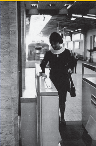
↑1966(昭和41)年3月、近畿日本鉄道・大阪阿部野橋駅で行われた実証実験と使用されたパンチカード式通行証。
