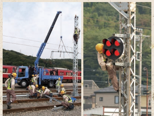
線路上を走行するクレーン車が到着。仮架線柱の復旧作業、信号機確認作業などが着々と進められる。
