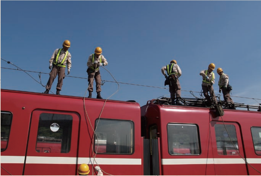
吊架線の仮復旧作業をすすめる。
