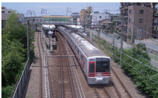
相鉄・JR直通線の連絡線敷設の始点となる西谷駅。
