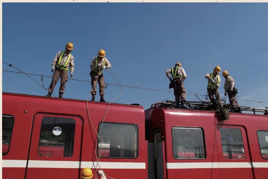
吊架線の仮復旧作業をすすめる。
