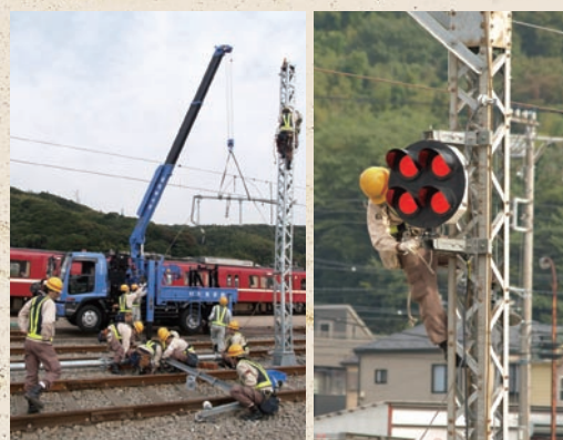
線路上を走行するクレーン車が到着。仮架線柱の復旧作業、信号機確認作業などが着々と進められる。
