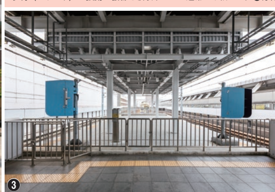
①荒川の鉄橋を渡るつくばエクスプレス（北千住駅～青井駅間）。②つくばエクスプレス総合基地は8両編成化に向けた拡張工事が進んでいる。（写真提供：首都圏新都市鉄道）③8両編成に備えたホームの延伸部分（北千住駅）。④線路に敷かれている砂利（パラスト）は振動と騒音を吸収するため通常より細かい。⑤万博記念公園駅前にある岡本太郎氏のモニュメント。
