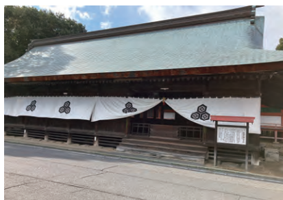
地御前神社の拝殿(上)。拝殿の前を横切る一般道を挟んで鳥居と狛犬。鳥居をくぐるための舗装された参道はない(下)。
